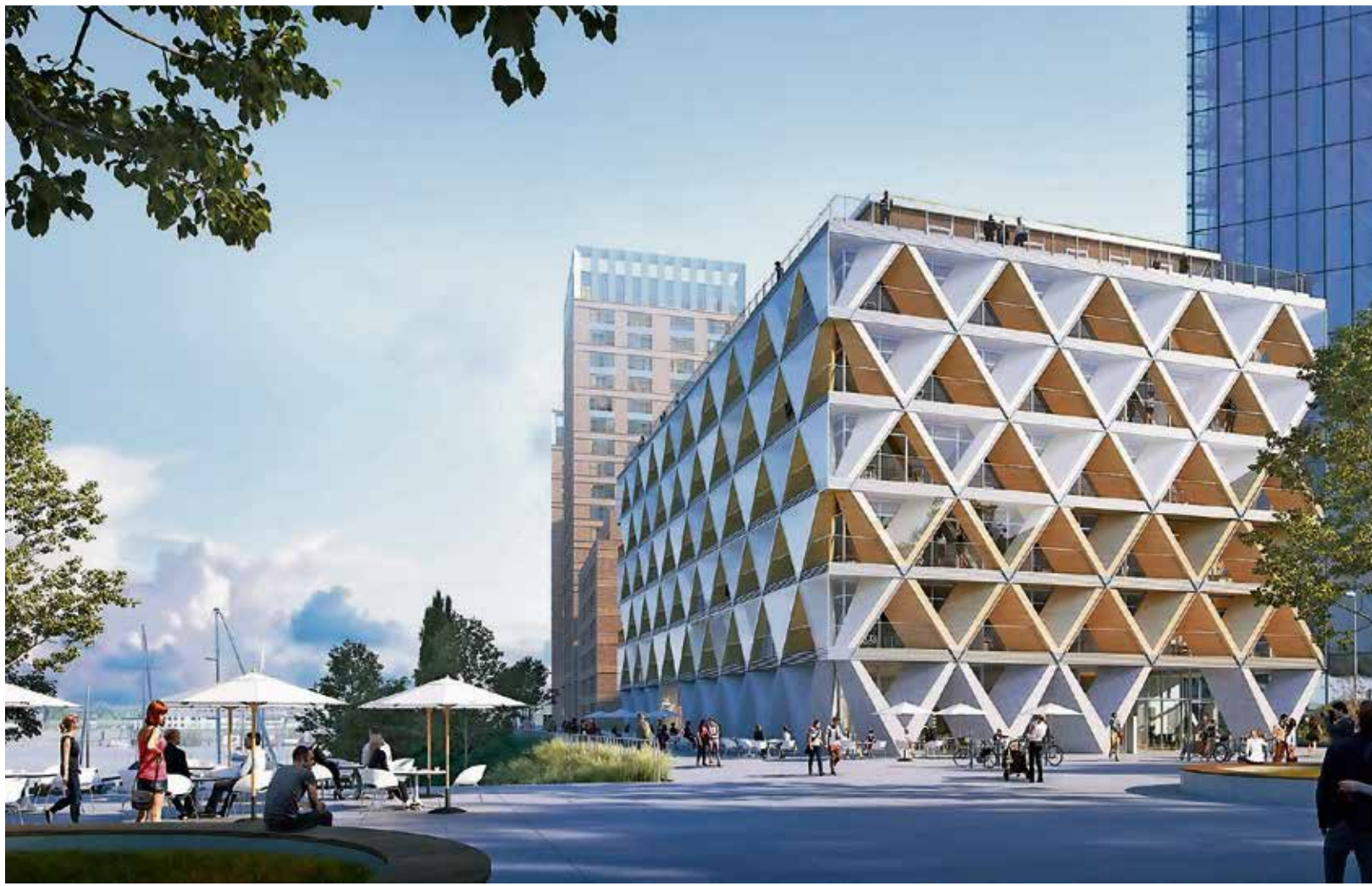
Ein Beispiel für nachhaltiges Bauen ist das für 2022 im Düsseldorfer Medienhafen geplante Bürogebäude in Holzhybridbauweise „The Cradle“
